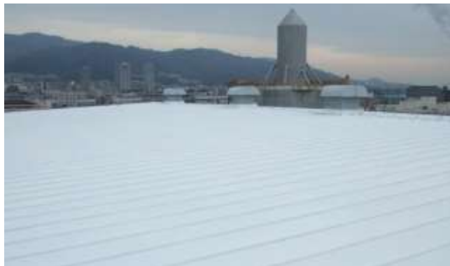
▲防水塗料の塗布完了
